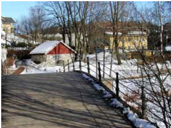
Løkke med Løkke bro og vognskjul.
