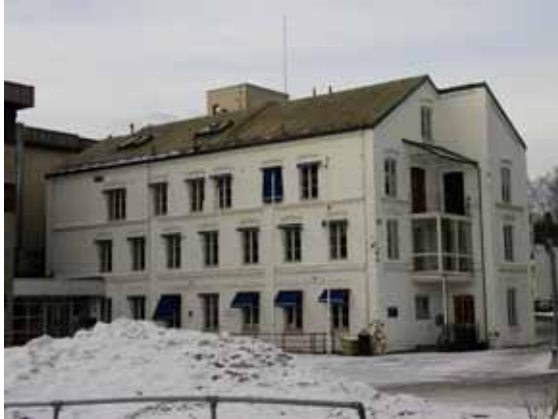
Fabrikken Tomten i Industriveien
